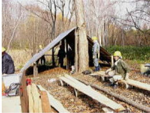
写真は澄川の森でヤナギの枯幹をつついている場面です。澄川では沢地の一部とか池のある湿地にヤナギ類が侵入していて、当ボランティアが基地としている場所に大木に成長した1本があります。そのヤナギの幹を柱の片方にして、小屋を作りました。図面なしにああしよう、こうしようと現場で試行錯誤しながら出来上がりました。越冬用として機材収納や風雪避けに活用されることでしょう。
