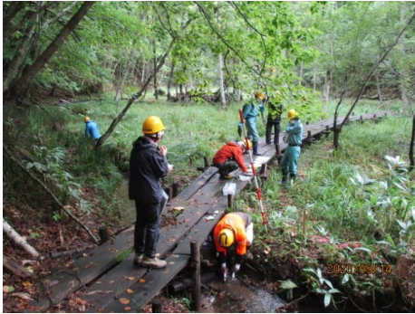
調査風景(上流橋)
