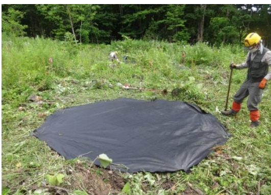
敷設した八角形の防草シート
