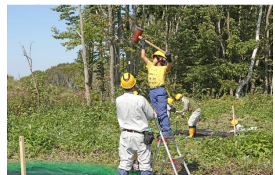
食害防止用ネット張りのポール打込み
