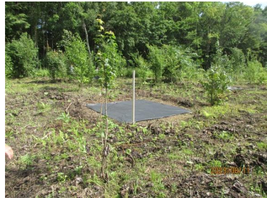
防草シート布設(2023年8月11日)
