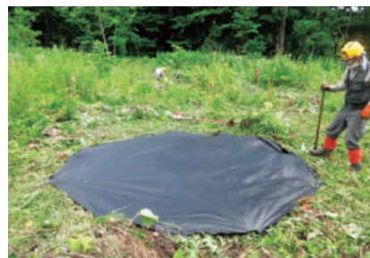
敷設した8角形の防草シート
