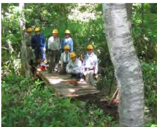
橋は完成しました。旧橋とは構造が違います。橋脚なしで長さ4mの太めの丸太2本を桁にして、天板を貼る形です。新橋の方が渡るに安定感があります。リヤカーも渡れます。距離も短くなりました。丸太を運ぶのに新設備のエンジン式ウィンチが活躍しました。チルホールをエンジン駆動するようなものですから、架線方式は皆なじんではいけません。高齢者集団なので腰や膝を痛める危険を減らす優れものであることが良くわかりました。
